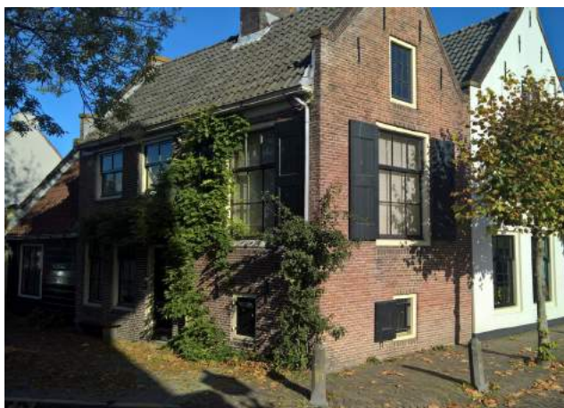
Kantoor Rabobank (1981-1993) hoek Kleiweg en Brugstraat
